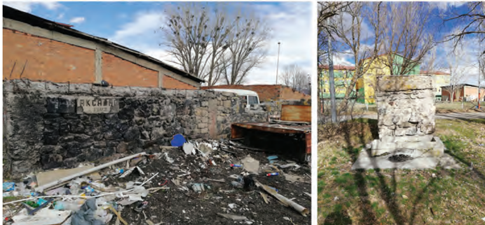
Resim 13. Pulur Köy Enstitüsü yerleşkesinin güncel durumu
