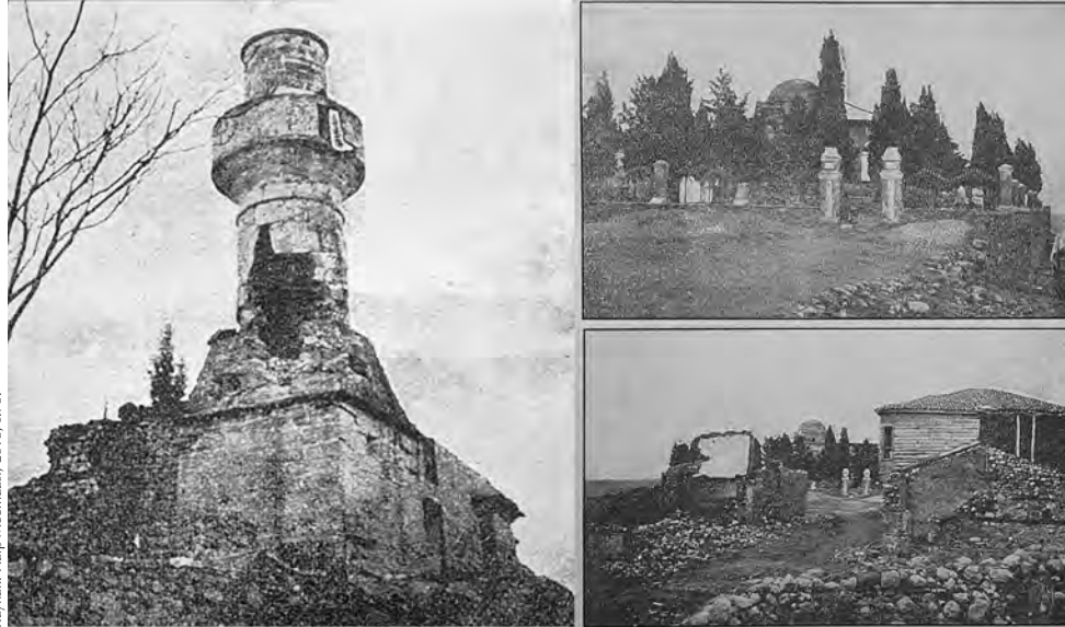
8. Gazi Süleyman Paşa Türbesi’nin 11 Nisan 1915 tarihindeki saldırı sonrası durumu
