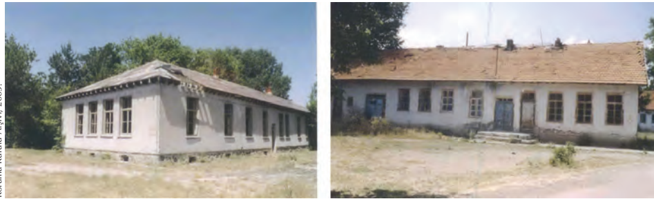
Resim 8. Pulur Köy Enstitüsü dönemine ait yapıların 2003 yılındaki durumları
