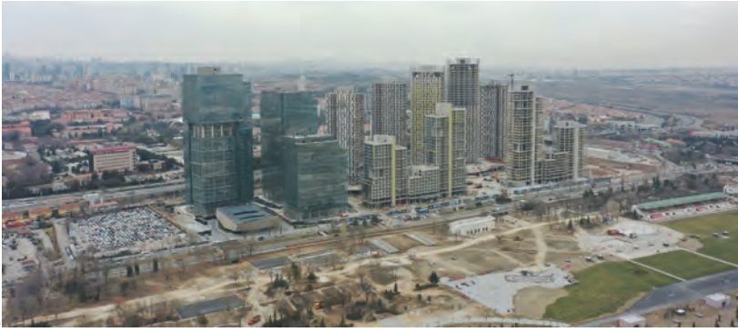
5. Merkez Ankara inşaat aşaması
